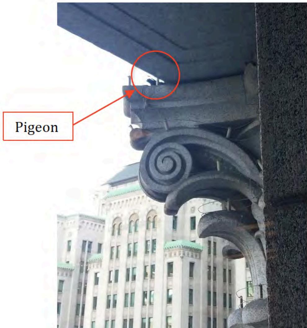
Un échantillon sera de caller une pente entre le chapiteau et l'architrave au-dessus pour empêcher/décourager les pigeons d'atterir ici. Un autre échantillon sera de fixer les pastilles de 'gel optique 4-s'. Notez que les fils et poteaux électrifiés ont été installés dans les années '80. On les enlèvera seulement aux endroits où on les remplacera par de nouveaux systèmes (au 3<sup>e</sup> et 4<sup>e</sup> étages et sur deux chapiteaux de colonne. (voir plans et devis)
