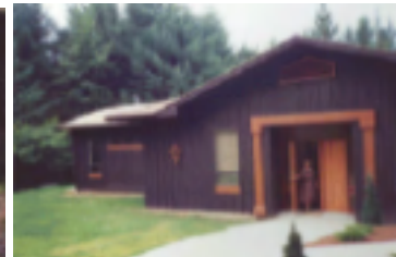
l'entrée, à la droite, la bibliothèque, la rampe et la chapelle
