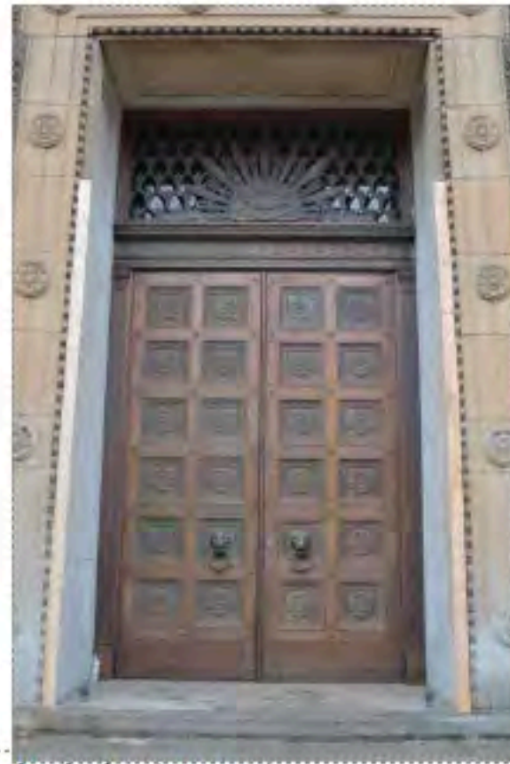
Après les travaux
