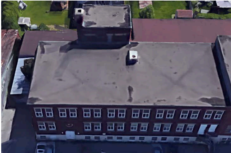
(fig. 1) Toiture (Google Earth)
