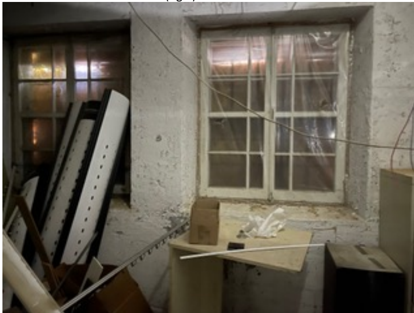
(fig. 5) Fenêtre du sous-sol
