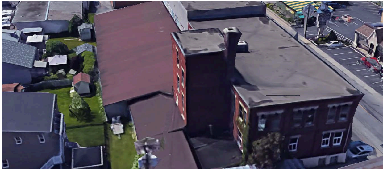
FAÇADE NORD (L'immeuble est en sérieux contraste avec les bâtiments résidentiels à l'arrière et leur enlève de la valeur)
