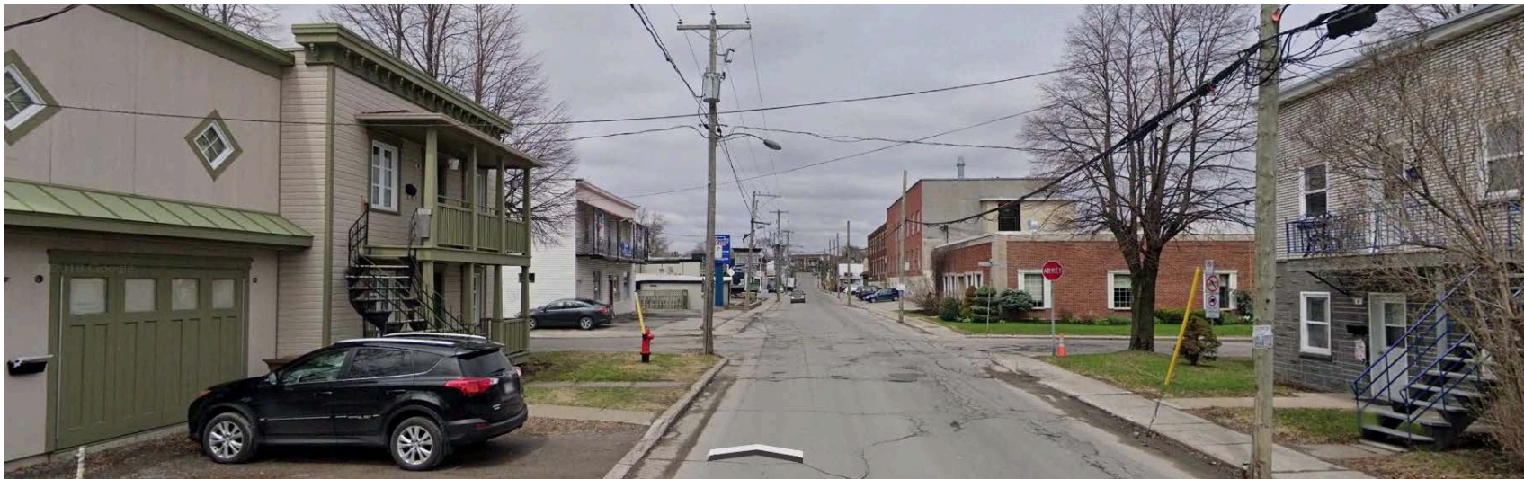
VUE DE L'ENTRÉE DE LA VILLE RUE CHAPLEAU (LOGEMENTS MULTIFAMILIAUX BIEN ENTRETENUS)
