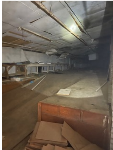
(fig.4) Le sous-sol
