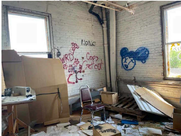
(fig. 3) Murs intérieurs et tuyauterie
